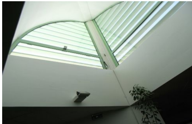
※ 省エネのため、採光を工夫している小学校の天井
