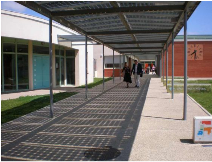
※ 渡り廊下の屋根に設置されている太陽光パネル
